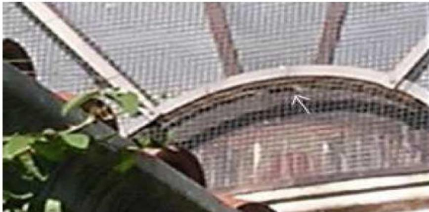
fig. 4 - Particolare del punto (freccia) dove la rottura del vetro, nella parte centrale (striscia scura fra due saldature bianche ) della finestrella, permette la penetrazione dei raggi solari.
